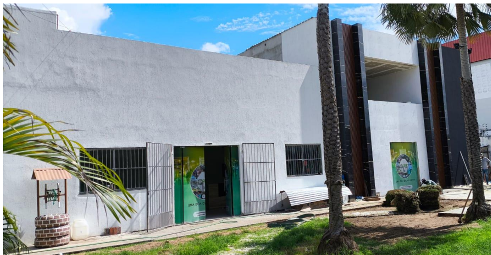
Figura 66 Fachada em reforma da sede do SISAR BAC em Sobral
