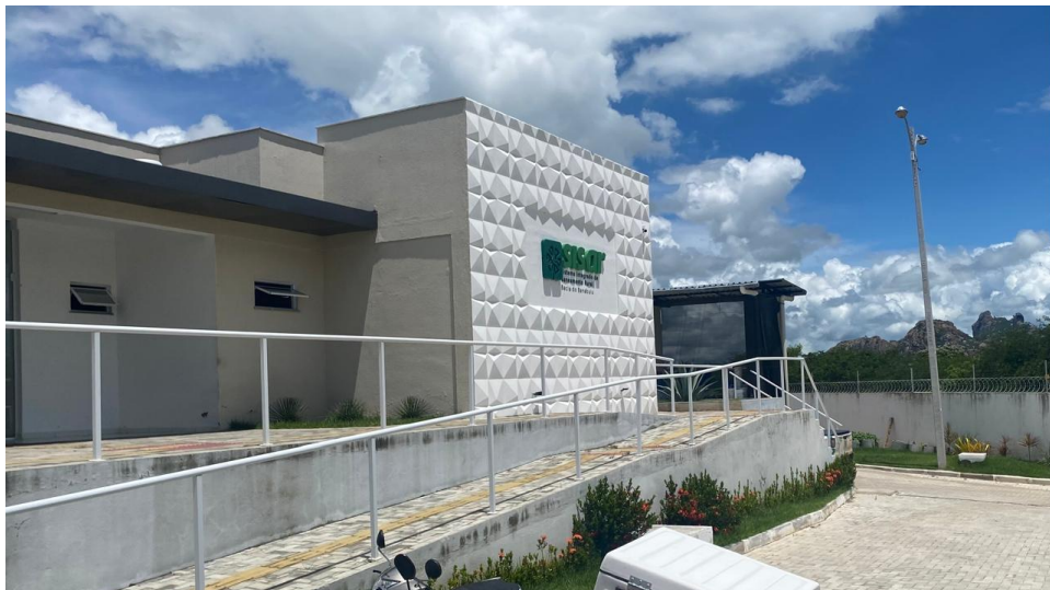
Figura 70 Fachada do SISAR BBA
