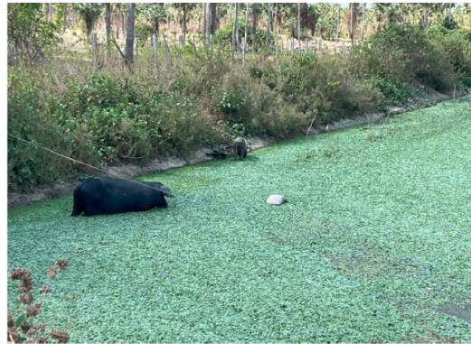
Imagem 10 – Presença de animais na Estação de Tratamento de Esgoto – ETE
