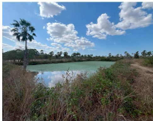
Imagem 09 –Estação de Tratamento de Esgoto – ETE
